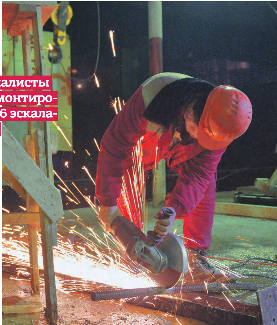
Рабочий Хаит Бурхунов во время строительства БКЛ «Сокольники»
