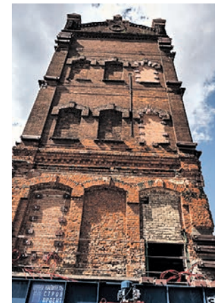
30 июля 2020 года. Водонапорную башню подняли над фундаментом
