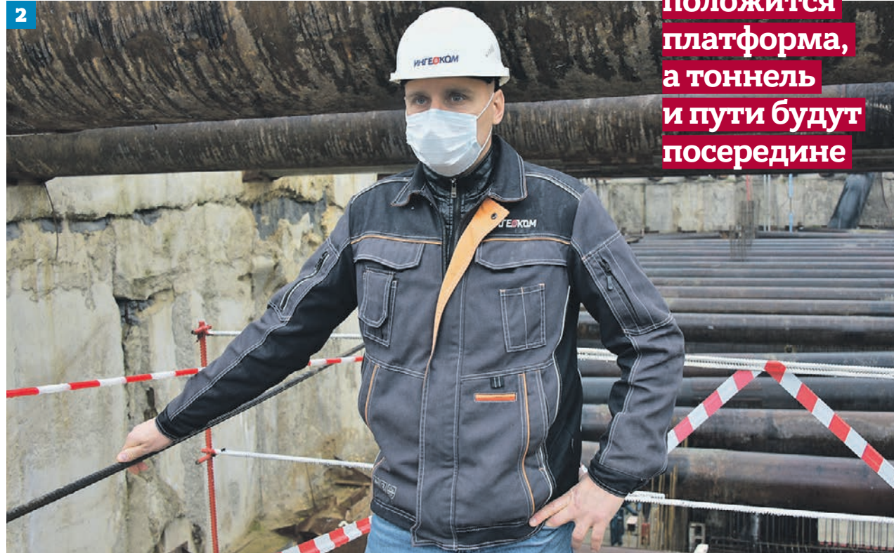
12 октября 2020 года. Начальник отдела строительного контроля АО «Объединение «Ингеоком» Дмитрий Ширшов (2) Строящаяся станция «Мневники» (1)
