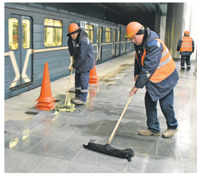
2 ноября 2018 года. Рабочие готовят станцию «Беломорская» к открытию
