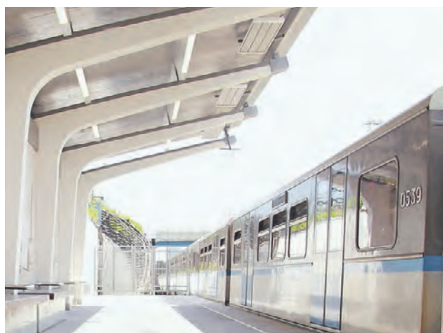
► 30 июня, 2017 года. Навес на станции метро «Студенческая» с инфракрасными обогревателями
