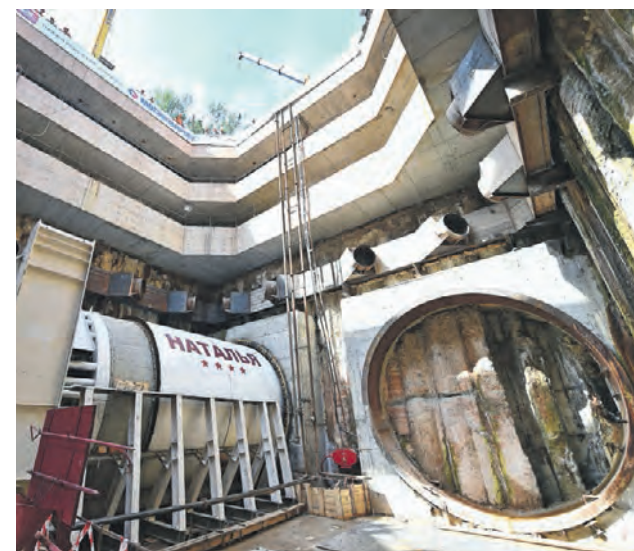
▶ 29 июня 2017 года. Щит «Наталья» готов к запуску от площадки, расположенной у стадиона «Металлург»
