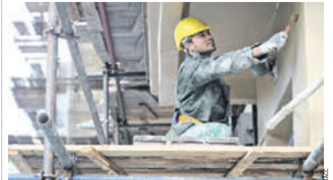
С учетом корректировок в плане капремонта жилых домов столицы отремонтируют 2154 фасада и 624 системы газоснабжения
