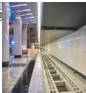
21 марта 2016 года. Пути на станции «Деловой центр»
