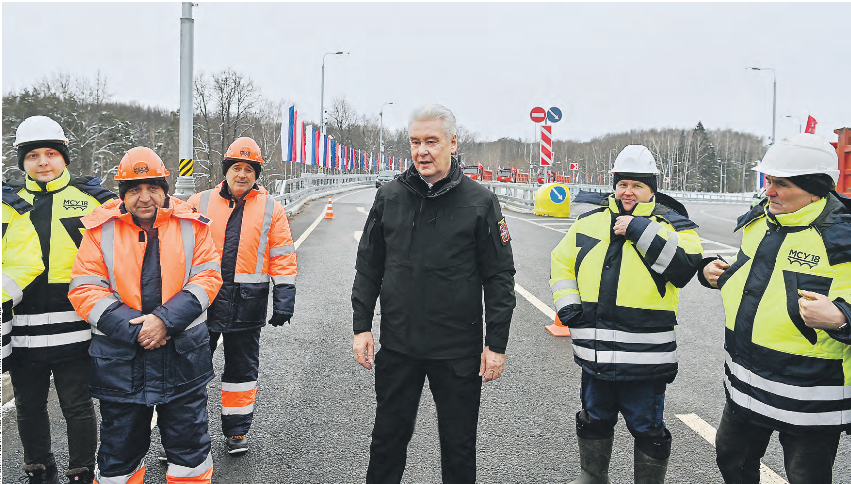
29 января. Мэр Москвы Сергей Собянин (в центре) открыл движение по двум путепроводам в районе торгового центра на 41-м километре МКАД. Строители сдали объект на несколько месяцев раньше контрактного срока. Новые съезды улучшат транспортное обслуживание более чем 115 тысяч жителей столицы
