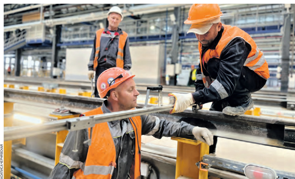
3 июня 10:33 Рабочие (слева направо) Олег Нурылев, Сергей Мышлянов и Эдуард Парасковей проверяют смонтированные пути в электродепе «Аминьевское»
