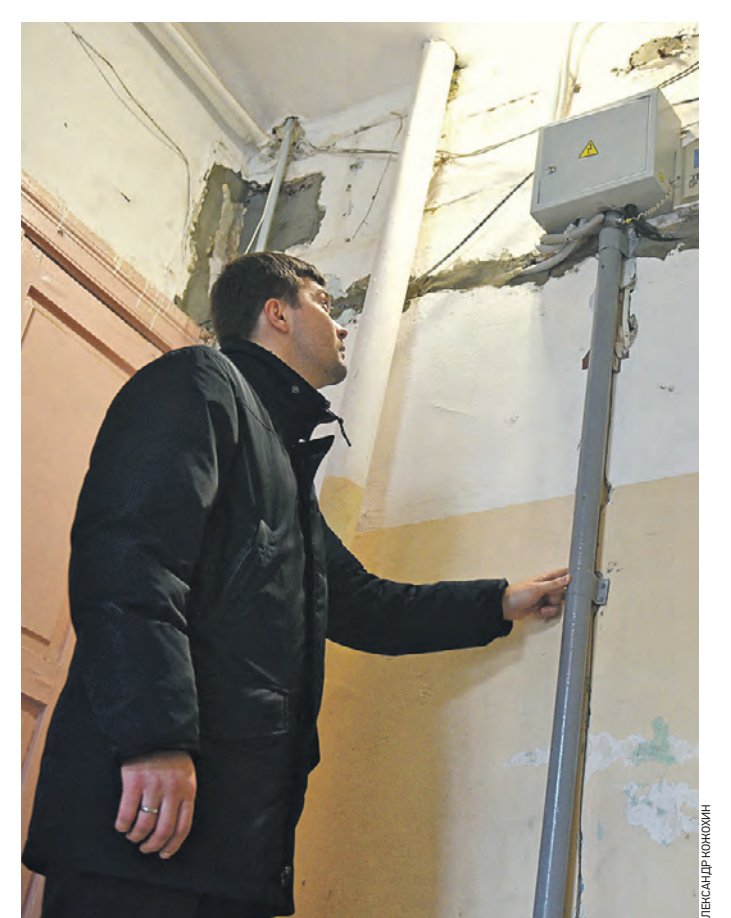
Вчера 11:07 Заместитель гендиректора столичного Фонда капитального ремонта Илья Байдуцкий контролирует выполнение работ по замене электроснабжения
