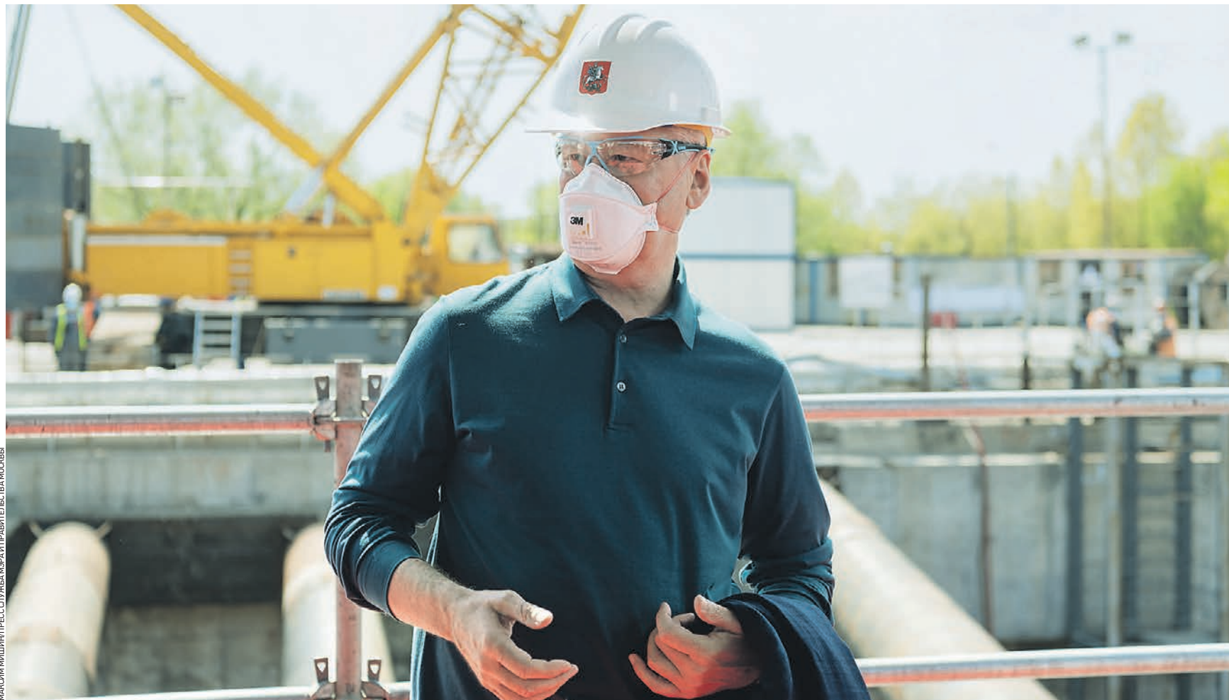
Вчера 11:05 Мэр Москвы Сергей Собянин на стройплощадке станции «Кленовый бульвар» Большой кольцевой линии метро. По его словам, строители соблюдают все необходимые санитарные нормы. Это нужно, чтобы не допустить распространения коронавирусной инфекции в столице
