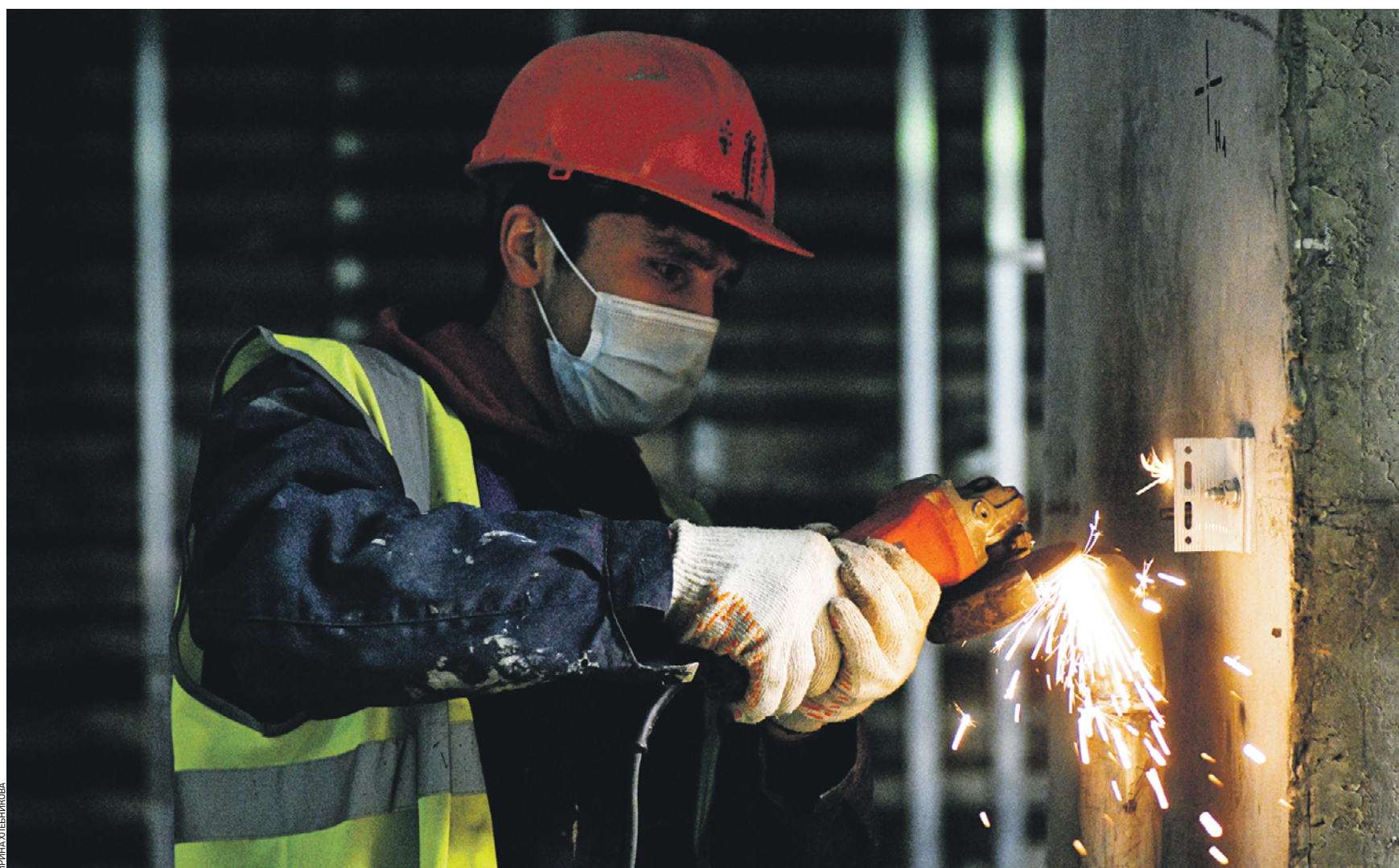
31 октября 10:43 Строитель Руслан Романов во время работ на станции «Улица Народного Ополчения» западного участка Большой кольцевой линии метро. Сейчас готовность этого участка метрополитена, который включает в себя четыре станции, — 60 процентов
