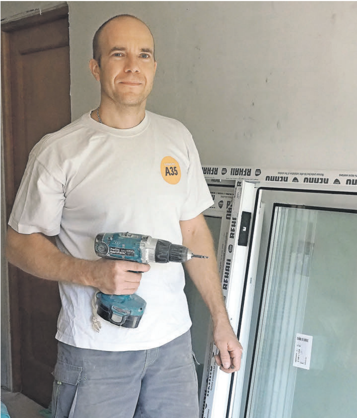
19 сентября 12:17 Евгений Николаев на объекте по адресу: 2-й Полевой переулок, 2, корпус 3. Евгений ремонтирует квартиры один, говорит, что это выгодно для всех
