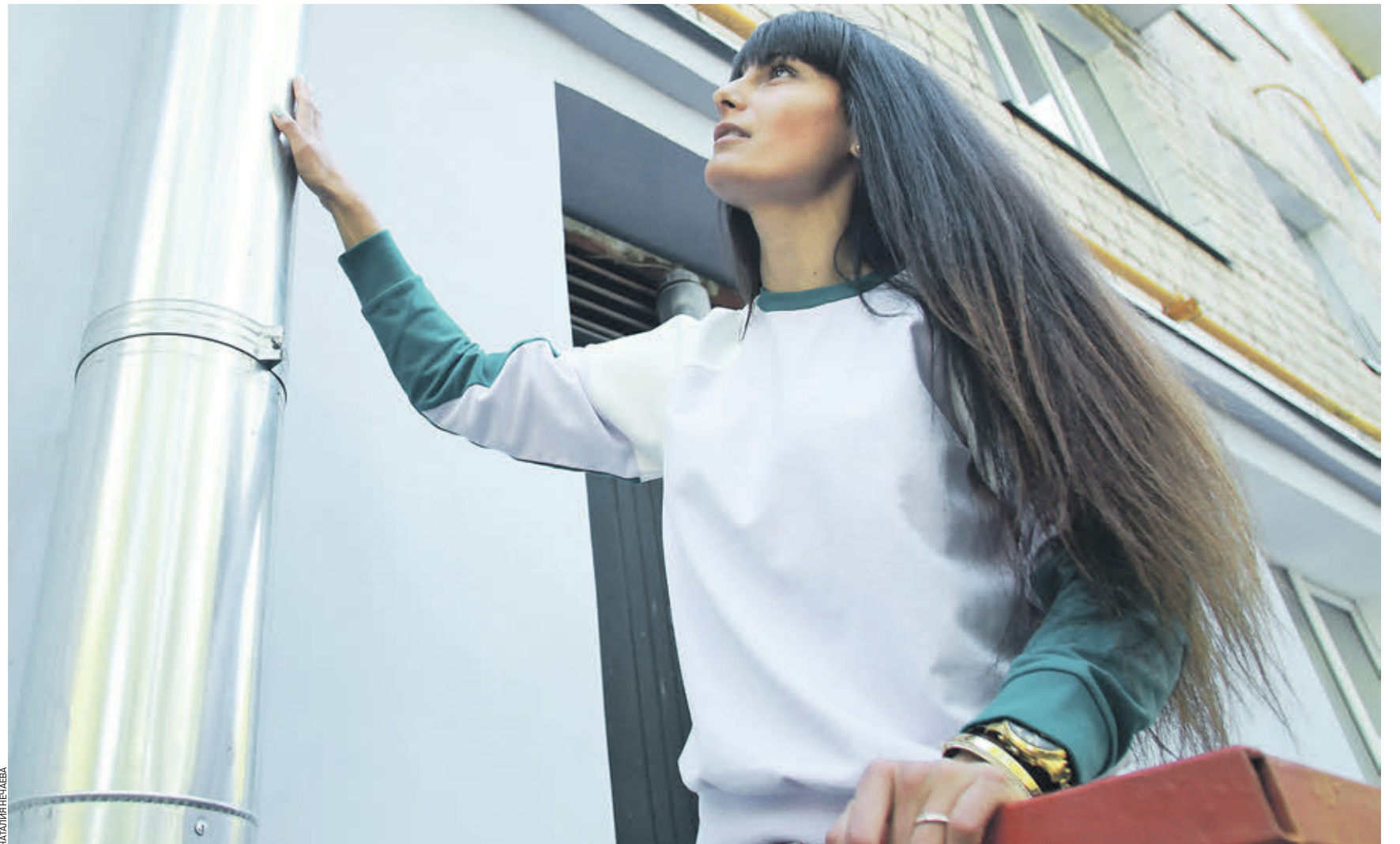
7 мая 2018 года. Ведущий специалист отдела ЖКХ Мещанского района Алина Малекьяр осматривает отремонтированный водосток дома на улице Дурова, 3/13
