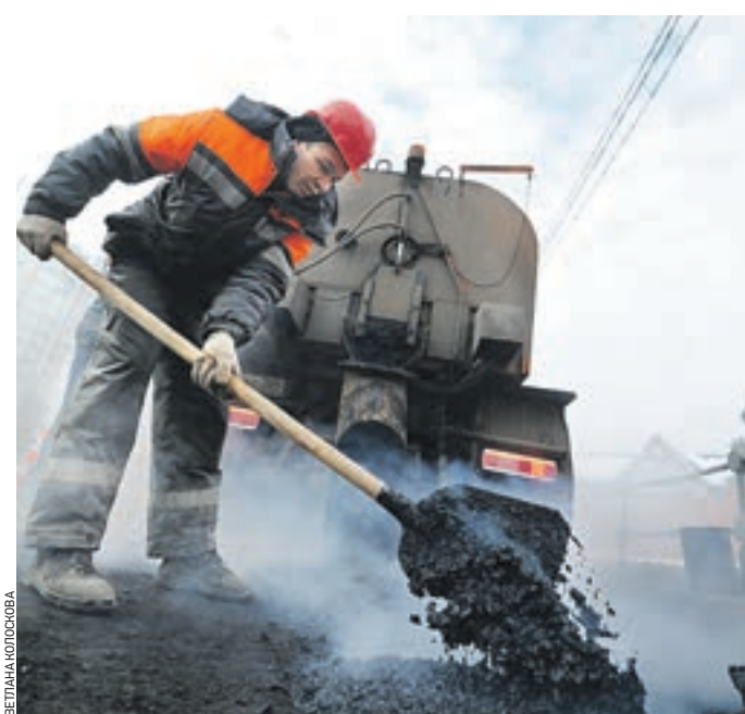
Вчера 11:20 Дорожный рабочий Антон Гордеев распределяет асфальт в дорожной яме
