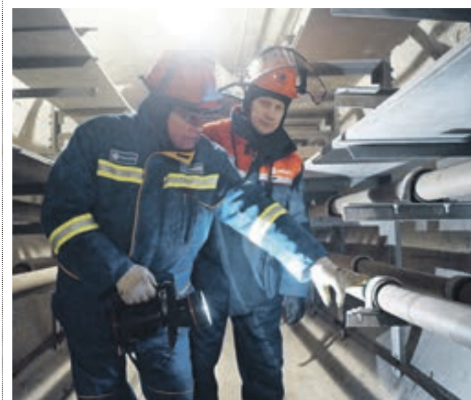
Вчера 11:34 Монтеры Юрий Маренков (слева) и Виктор Дроздов осматривают кабель в коллекторе «Кутузовский»
