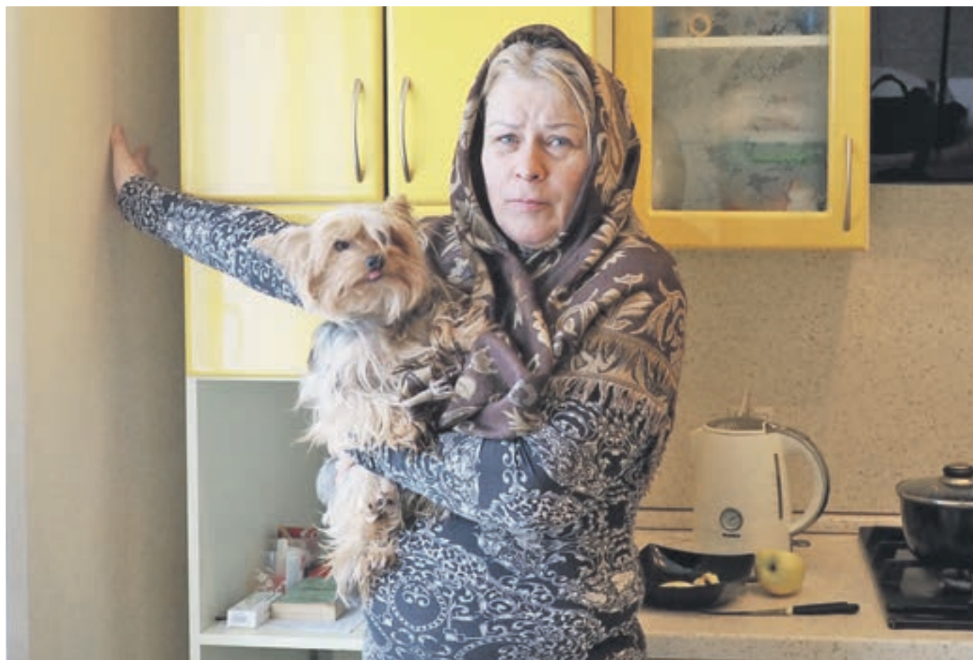
12 февраля 14:03 Жительница дома №76 на Шоссейной улице Светлана Левыкина жалуется на то, что в ее кухне стоит отвратительный запах, и она мерзнет, потому что в стене — сквозная дыра, из которой все время дует
