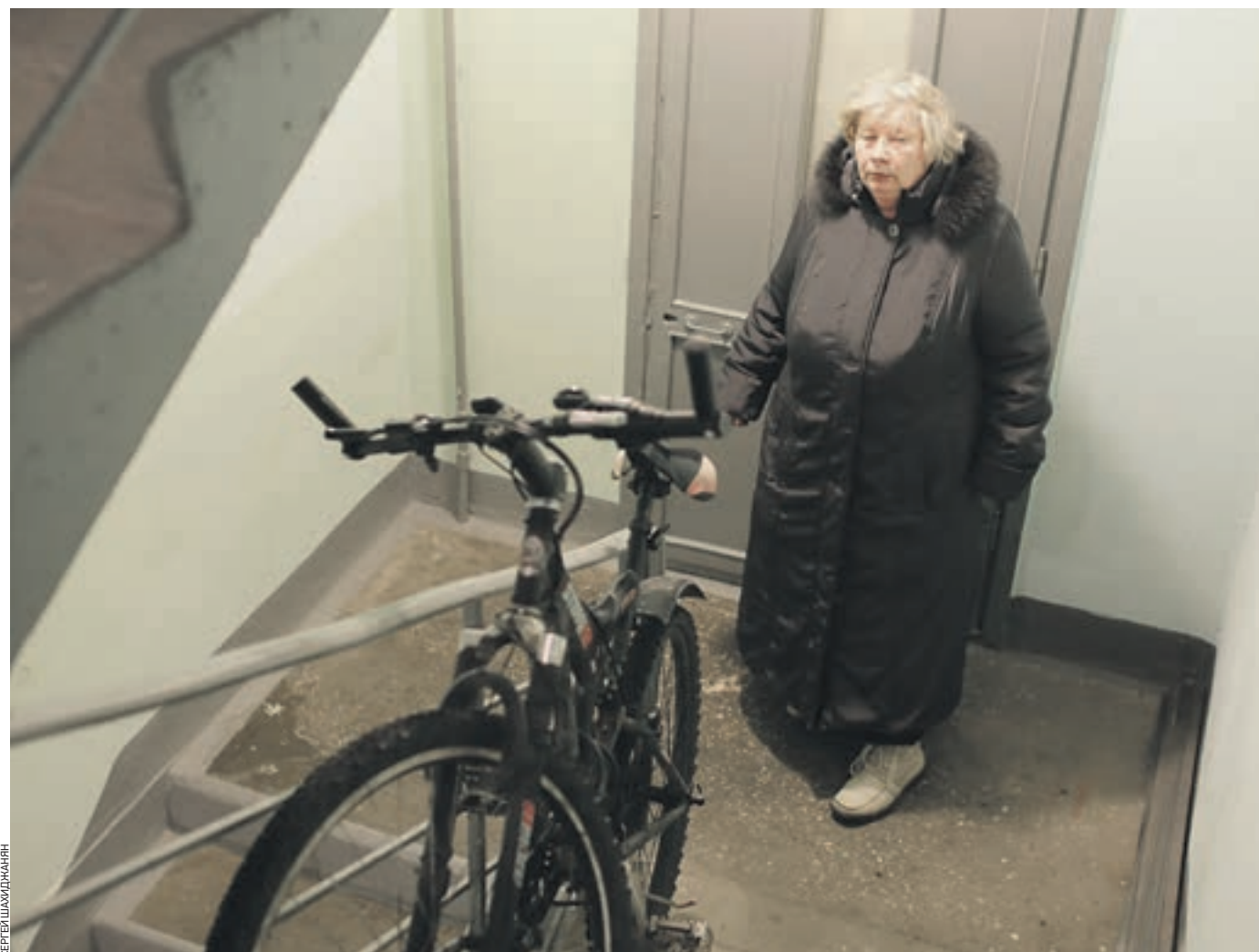
1 февраля 2018 года. Кировоградская улица. Жительница дома № 38/3 Валентина Пахомова показывает спецкорреспонденту «ВМ» свой подъезд. Однако жалобы на ужасное состояние подъезда на месте не подтвердились
