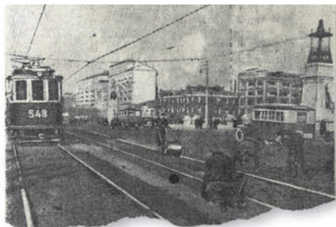
«Вечерка» за 26 октября 1943 года. Асфальтирование путепровода на Ленинградском шоссе
