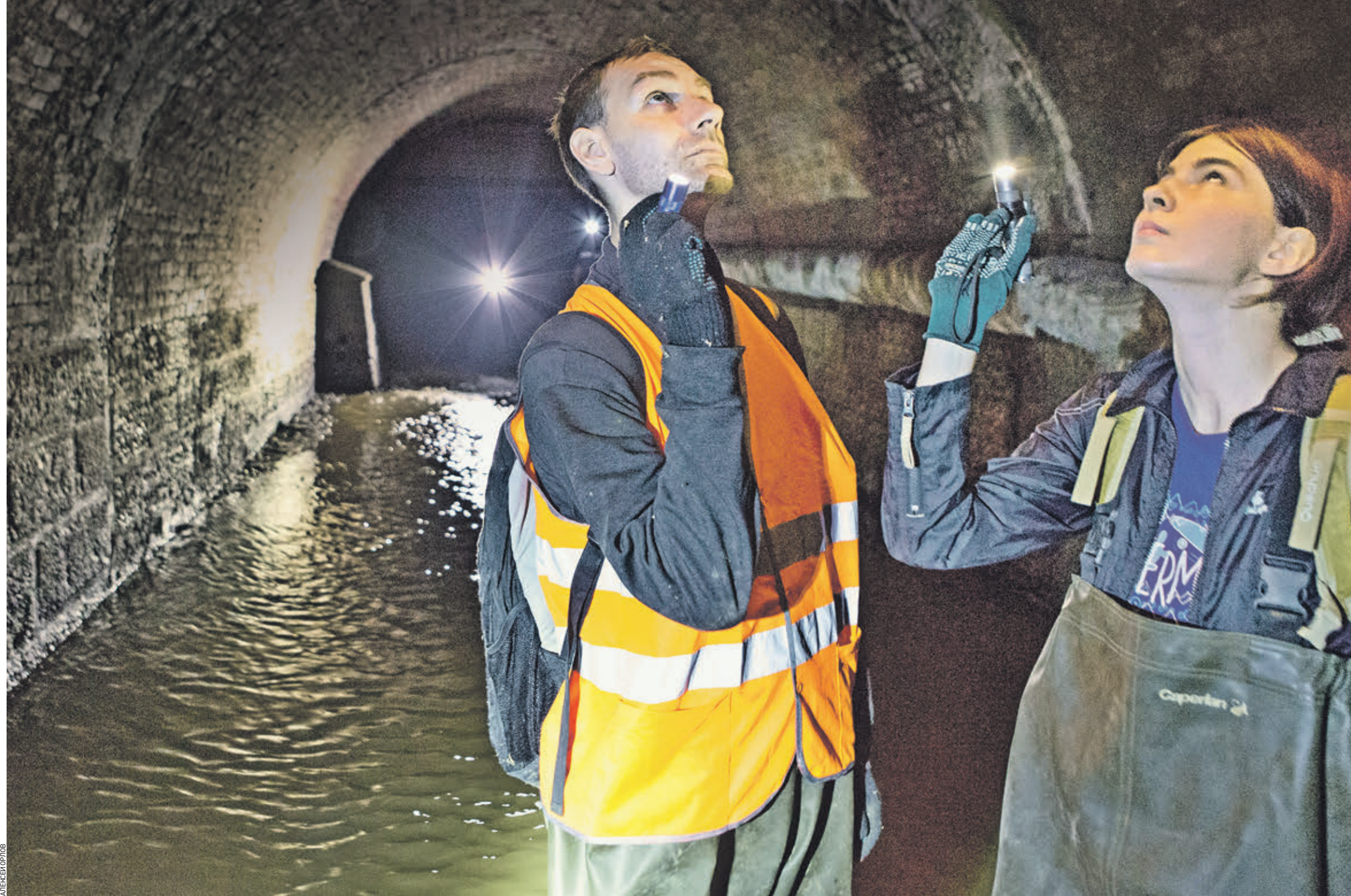
19 июля 2018 года. Специалисты отдела по изучению подземной архитектуры Московского городского отделения Всероссийского общества охраны памятников истории и культуры Геннадий Виноградов и Елизавета Ненашева осматривают построенный в середине XIX века подземный свод кирпичного моста Курской железной дороги в районе Текстильщики
