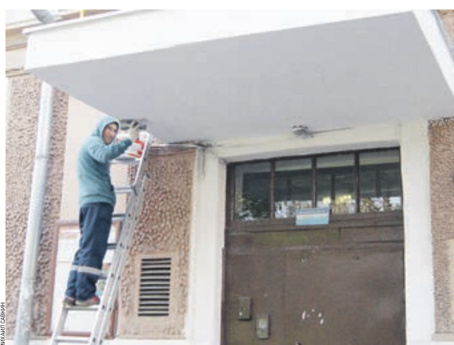
25 сентября 12:55 Кровельщик Роман Грасу заделывает последние трещины на подъездном козырьке дома № 2/5 в Карманников переулке
