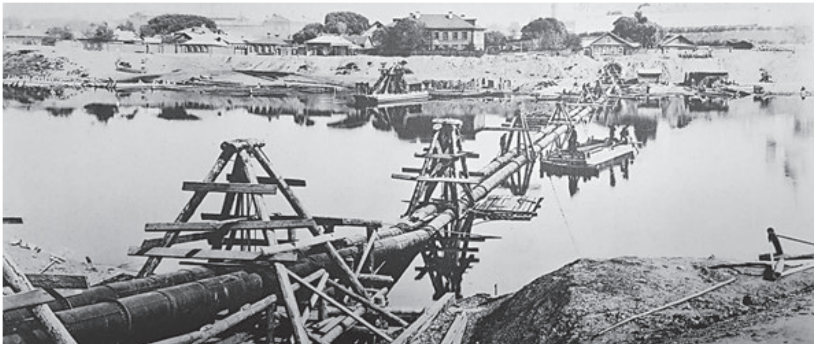
1890-е годы. Прокладка труб первой очереди канализационной системы Москвы. В целом строительные работы велись с 1893 по 1898 год
