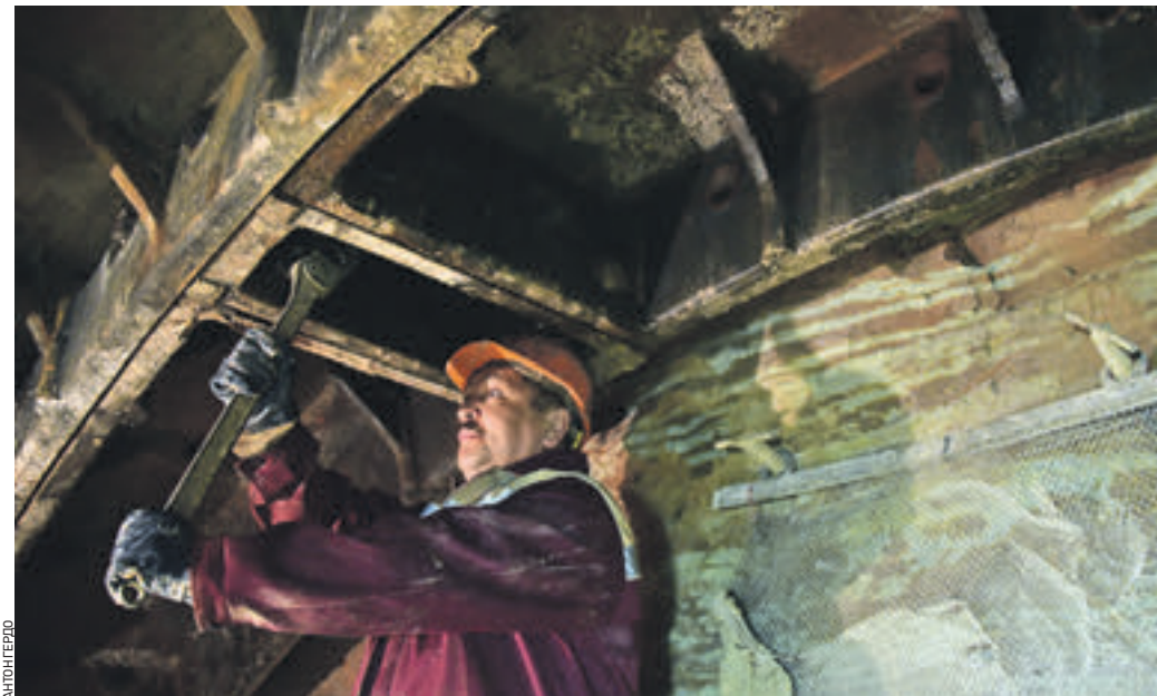
17 марта 11:17 Проходчик-метростровец Илья Ямалетдинов закрепляет тубинг. За смену рабочие должны установить полноценное кольцо. Работы идут на станционном комплексе «Нижней Масловки»
