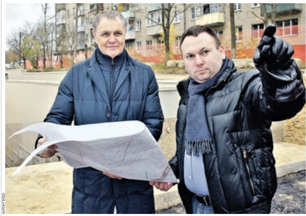
Вчера 09:49 Руководитель Департамента развития новых территорий Москвы Владимир Жидкин (слева) и его советник по дорожному строительству Дмитрий Гизетдинов инспектируют ход работ
