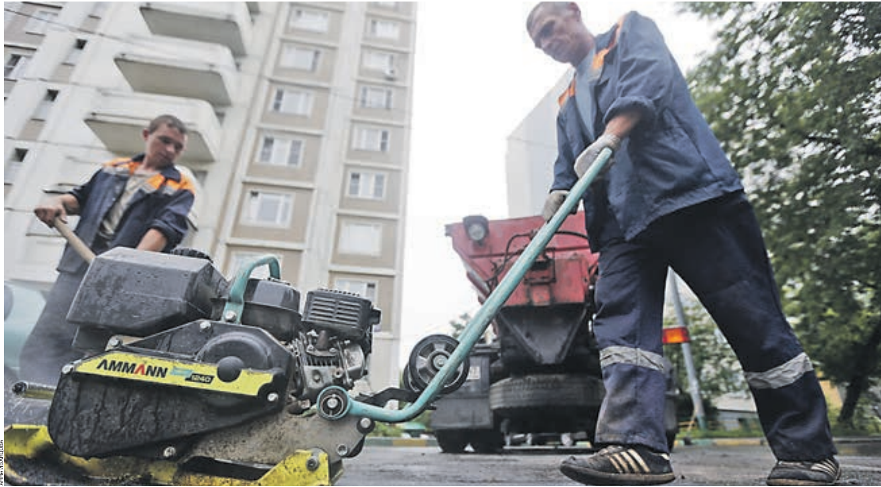
Вчера 14:15 Проезд Шокальского, 22. Сотрудники «Жилищника» из Северного Медведково латают дырки на проезжей части
