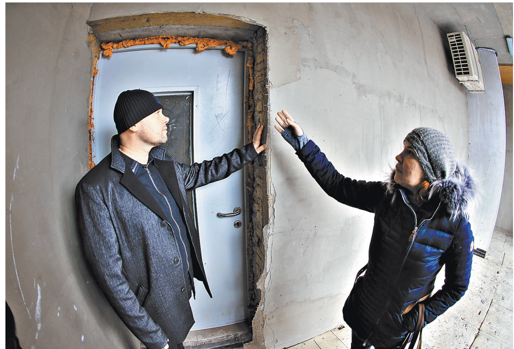
Искусственный разум сможет сам находить в проектах несоответствия параметров здания строительным нормам.
