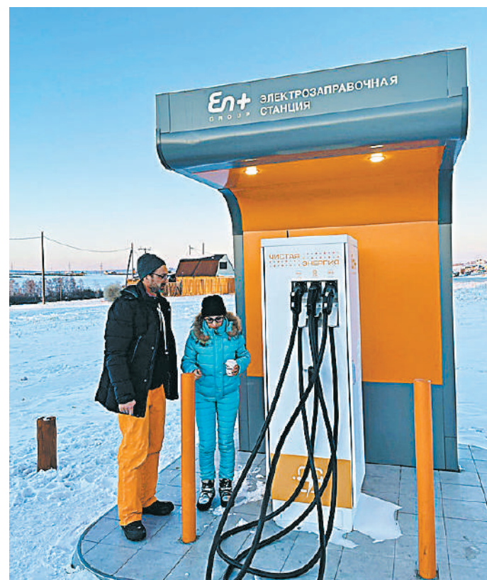
Электростанция на пути к Байкалу местным жителям привычна, а туристы-иностранцы удивляются.
