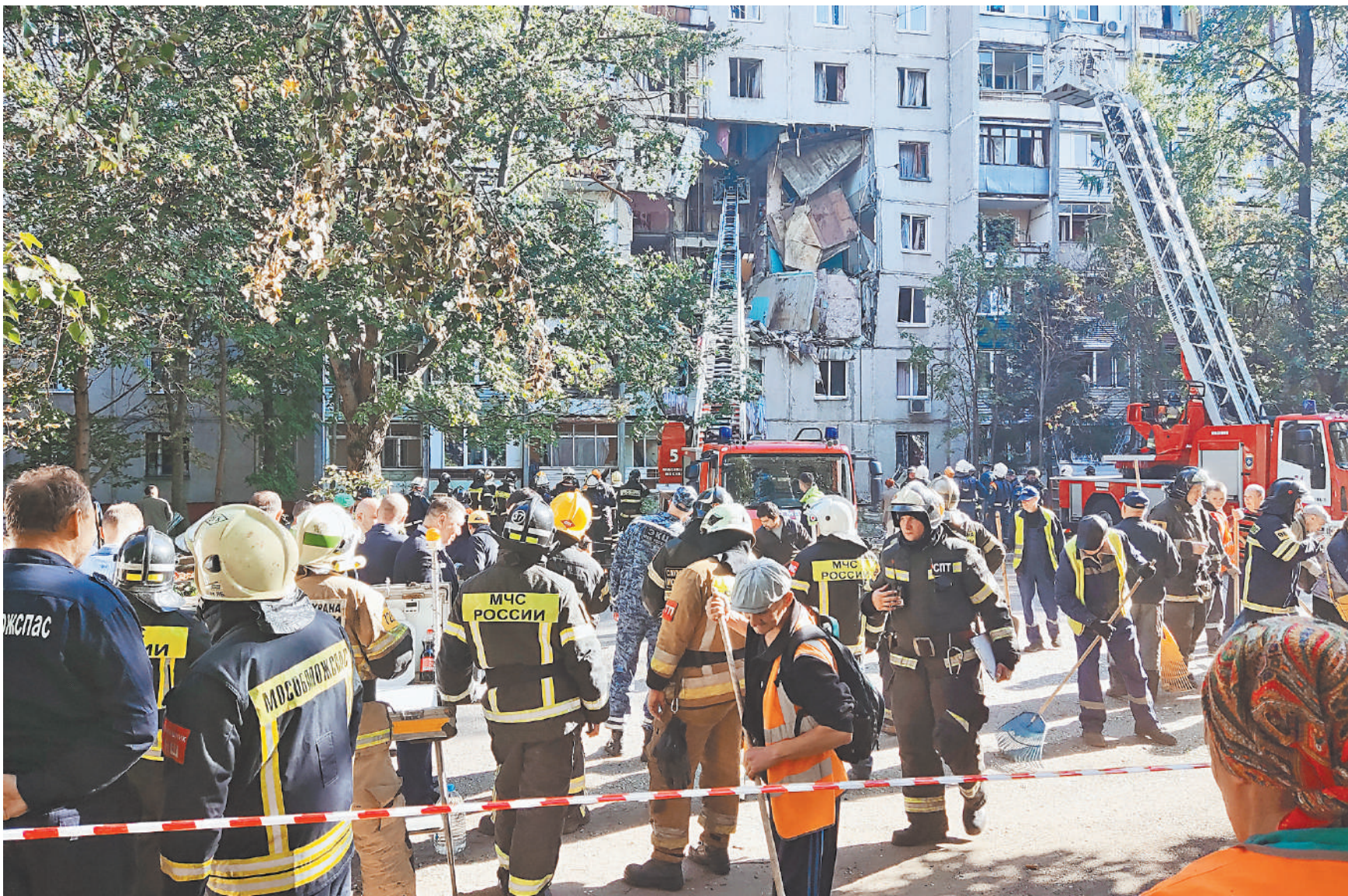
По предварительным данным, эпицентр взрыва находился в квартире на четвертом этаже.
