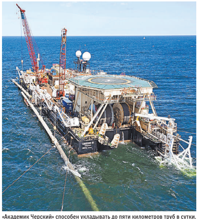
«Академик Черский» способен укладывать до пяти километров труб в сутки.
