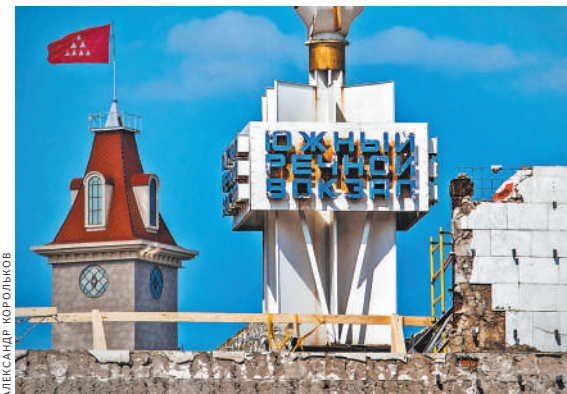
Реконструкция вернет зданию речного вокзала его исторический облик, обещают в стройкомплексе столицы.
