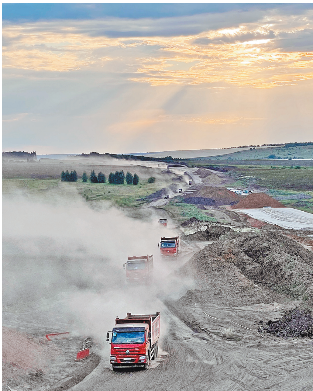
Грунт, грунт, грунт. Чтобы построить дорогу, его потребуется очень много. Огромный самосвал разгрузил свой кузов и... кажется, насыпь совсем не увеличилась. Но нет, подушка для будущей дороги прирастает. И постепенно станет той самой долгожданной скоростной трассой.
