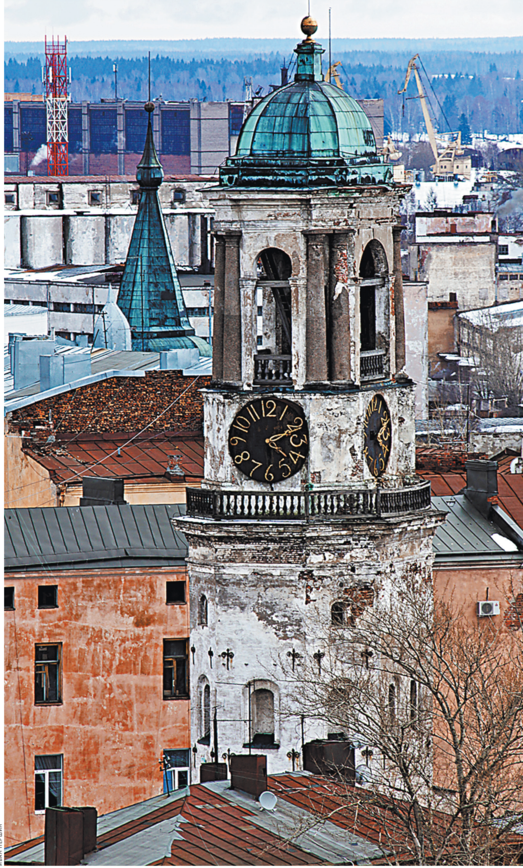
В прежние времена часовая башня выполняла функцию колокольни Кафедрального собора.
