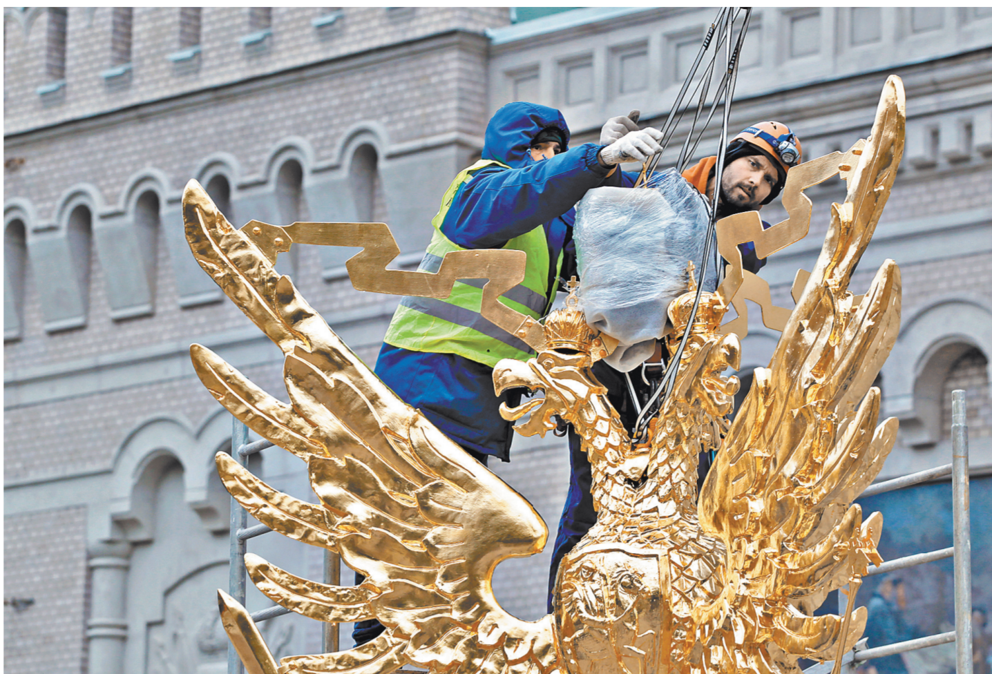
Отреставрированного двуглавого орла водрузили на башню мемориального музея Александра Суворова в Санкт-Петербурге. Для проведения этой непростой операции пришлось задействовать 40-тонный кран. На самом деле металлический позолоченный орел высотой 2,5 метра имеет три головы, однако это сделано специально для достижения необходимого оптического эффекта — герб России должен выглядеть двуглавым с любого ракурса. Реставрация заняла четыре месяца. По словам специалистов, обновленный орел продержится как минимум 25 лет.
