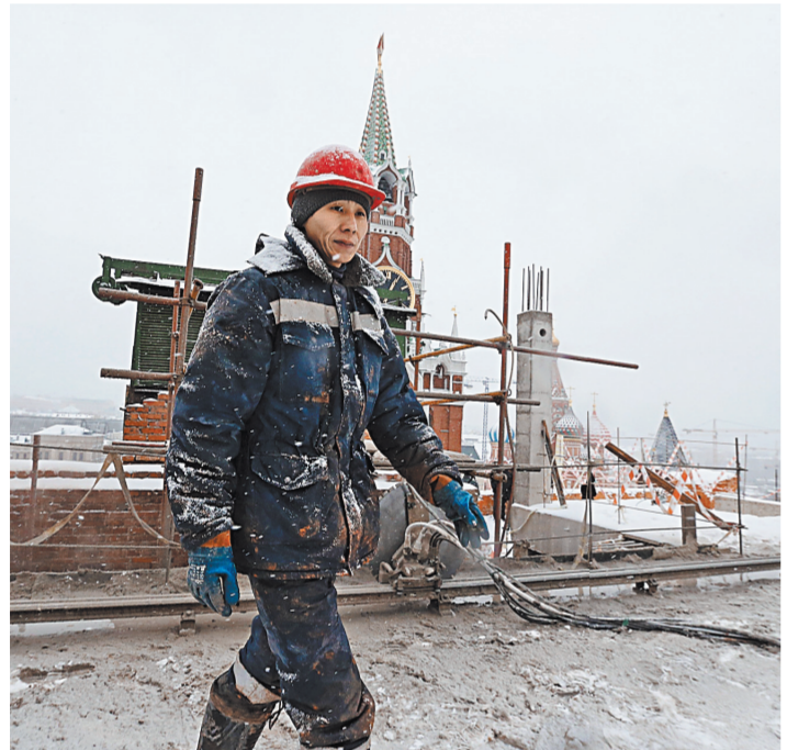
На крыше 14-го корпуса: оператор роботизированной пилы по бетону, за спиной которого Спасская башня.
