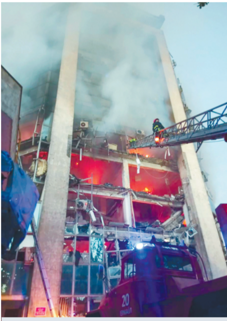
В порту Измаил разрушены элеваторы.
