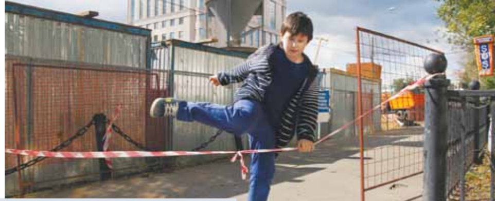
Рабочие копают фактически на территории самой школы №518, попасть к зданию стало еще сложнее.
