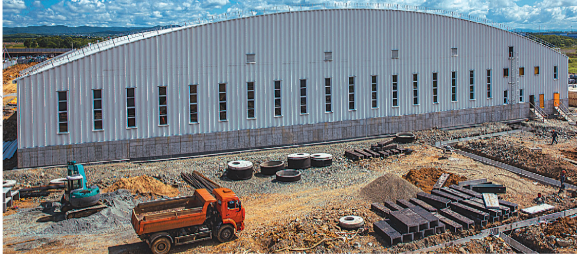
Строительство рыбоперерабатывающего комплекса выходит на финишную прямую.
