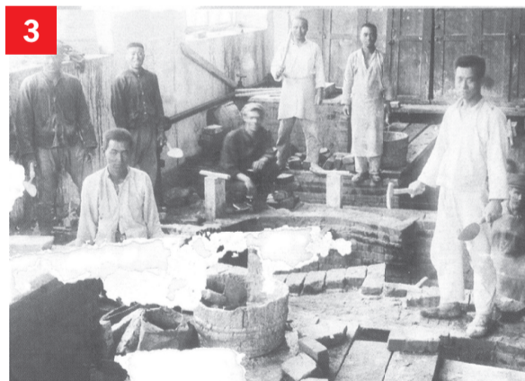
1) ВГЭС № 1 в 1932 году. 2) Кладка дымохода котла на ВГЭС. 3) Кладка котла Фитцнер и Гемпер, 1927 год. 4) Установка трубы на ВГЭС.
