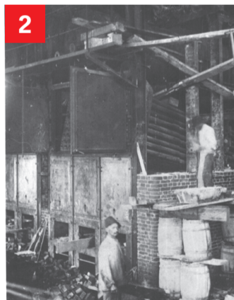
1) ВГЭС № 1 в 1932 году. 2) Кладка дымохода котла на ВГЭС. 3) Кладка котла Фитцнер и Гемпер, 1927 год. 4) Установка трубы на ВГЭС.
