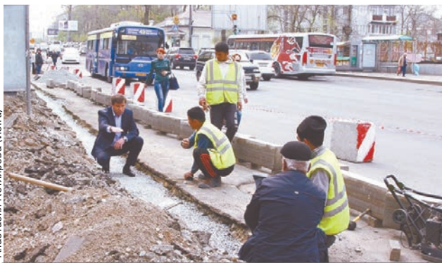
Качеству ремонта — особый контроль.
