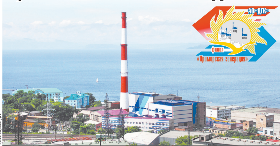
ВТЭЦ-1 обеспечивает теплоснабжением центр города.
