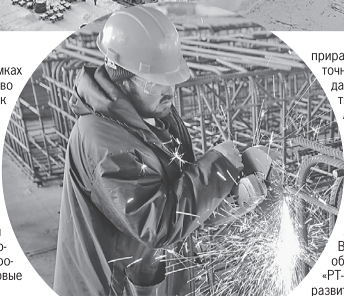
Монтаж оборудования на высокотехнологичном предприятии - дело тонкое.
