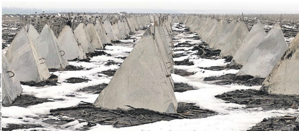
Рубежи ЛНР обкладывают вот такими бетонными пирамидами, которые никакая бронетехника с ходу не пройдет. Солдаты называют их «зубы дракона».
