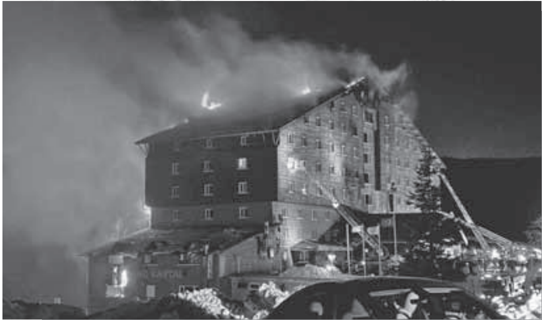
Облицованный деревом горный отель вспыхнул факелом. Сигнализация не сработала, автоматической системы пожаротушения в гостинице вообще не оказалось. Лестницы спасателей не доставали до верхних этажей, где люди оказались в огненной ловушке.
