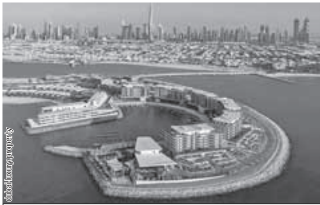
Комплекс Bulgari Marina Lofts. Дубай.
