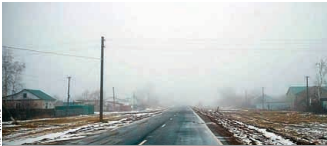
В 2023 году по нацпроекту отремонтировали свыше 420 км трасс региона.
