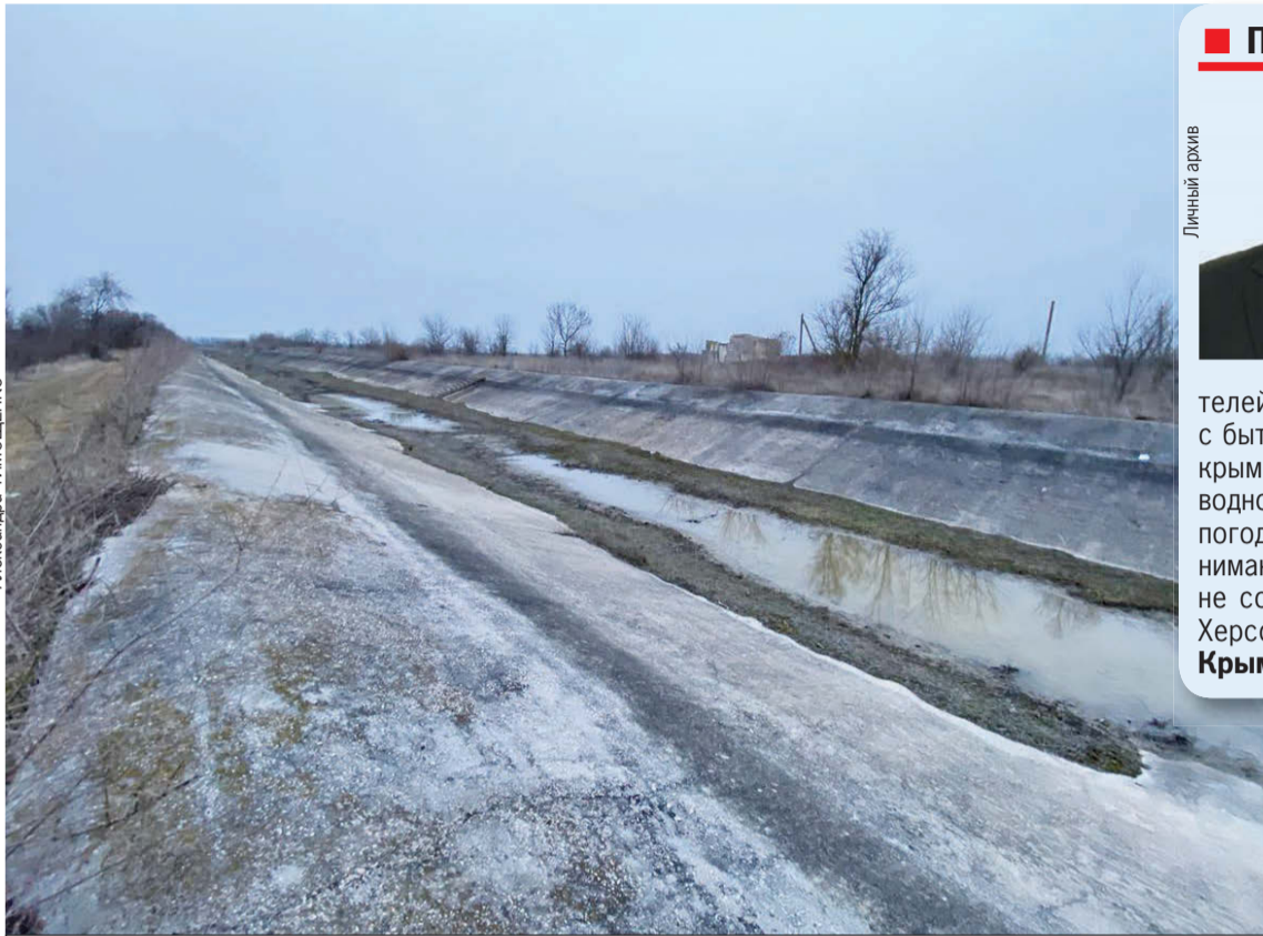
На работы по очистке канала уйдет не меньше двух недель.
