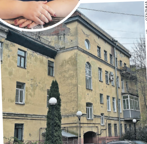
Марина (младшая сестра Ирины) тщательно проверяет будущих покупателей квартиры, которая находится на четвертом этаже этого дома.
