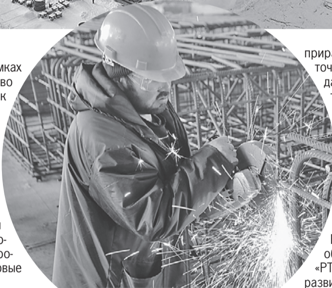
Монтаж оборудования на высокотехнологичном предприятии - дело тонкое.
