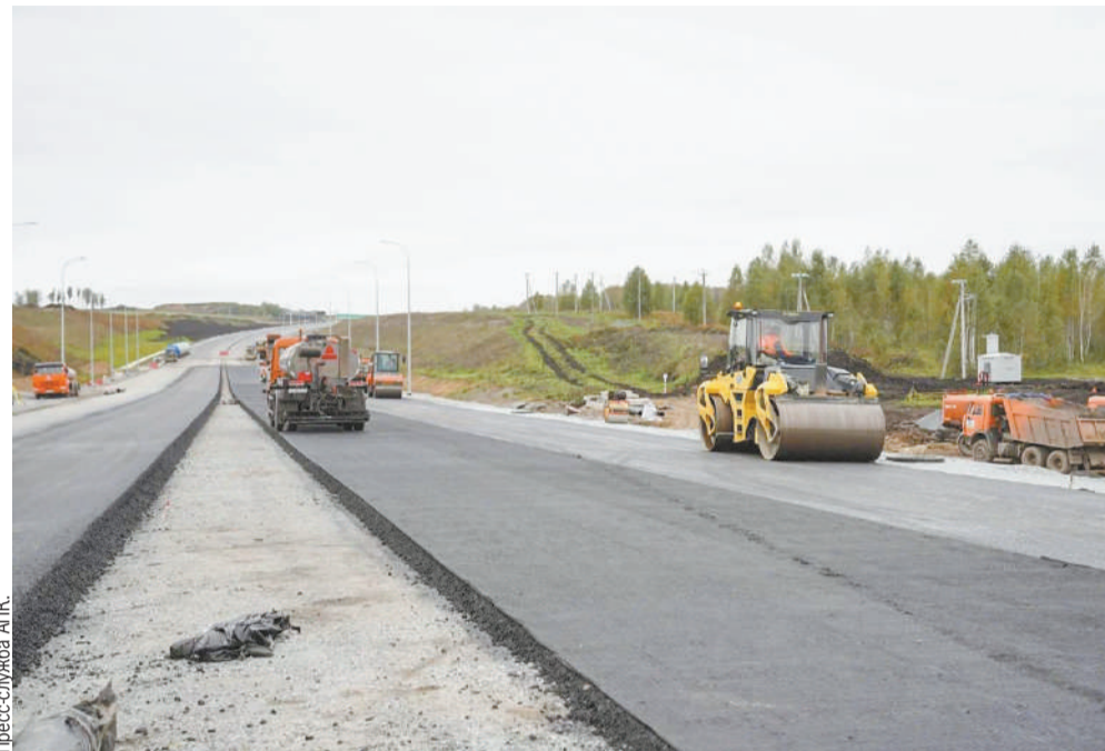
Работы еще ведутся на пяти участках Северо-Западного обхода, но их должны завершить до 15 октября.
