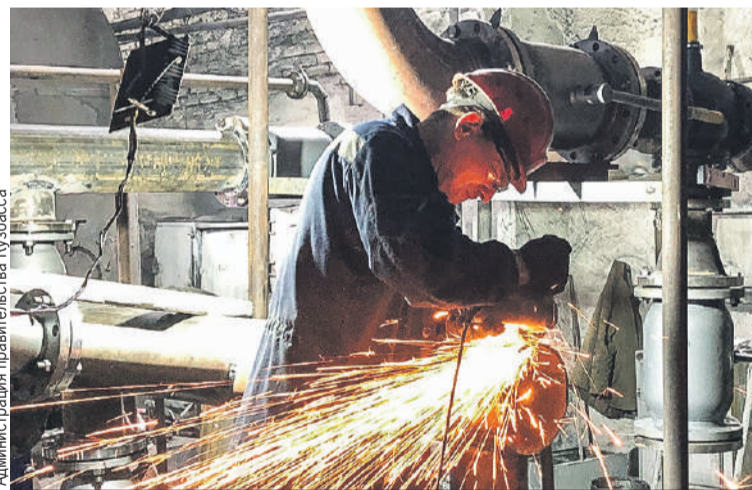
В городе проводят реконструкцию самой крупной котельной, тепло от которой поступает в квартиры каждого пятого жителя.
