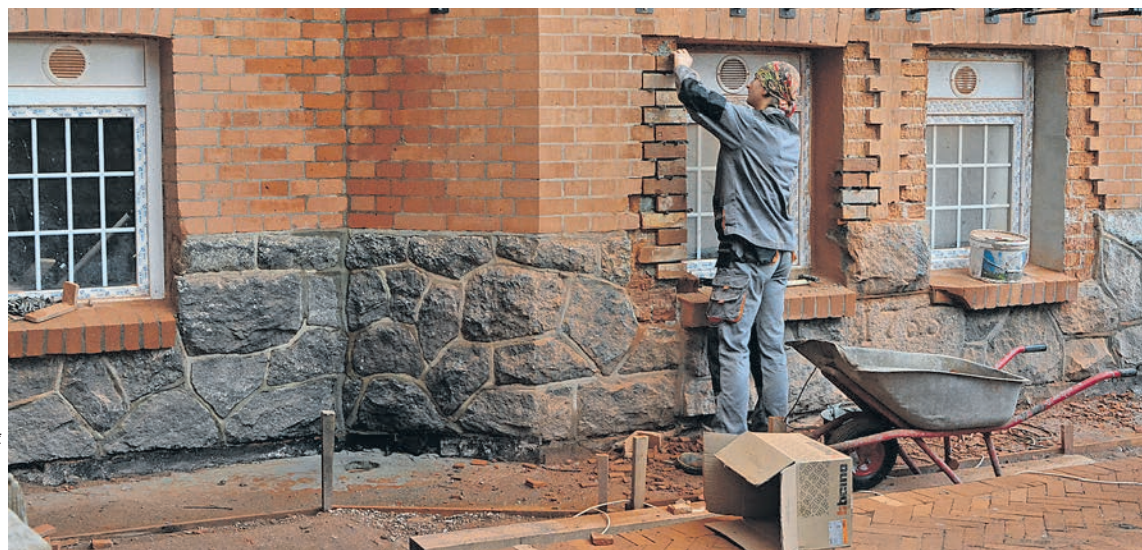
Сейчас продолжают работы во внутреннем дворе дома.
