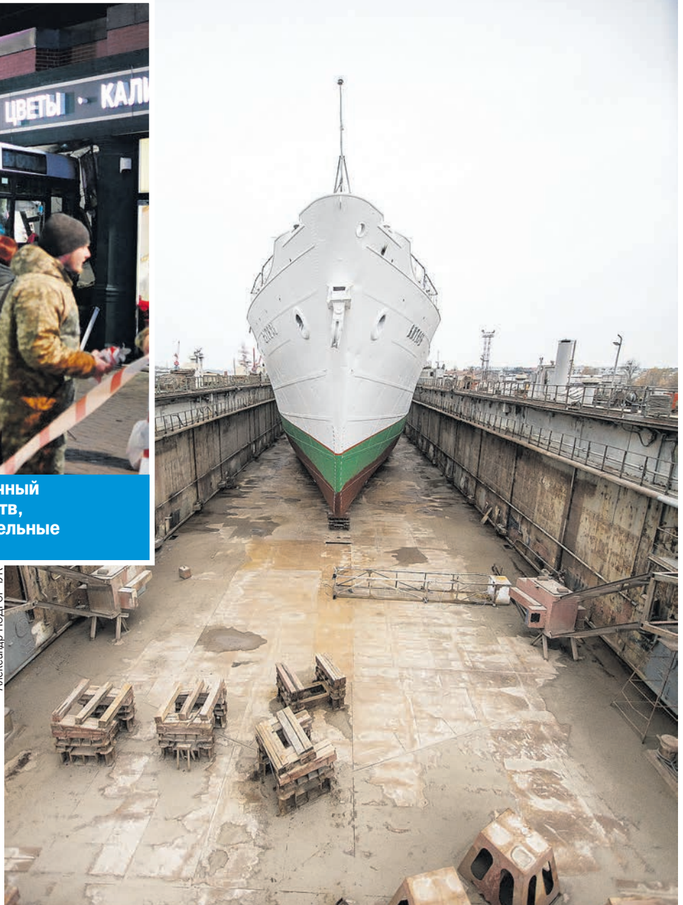
В ноябре завершился доковый ремонт легендарного судна «Витязь» на Светловском судоремонтном заводе. Корабль покинул сухой док, где рабочие очистили и покрасили подводную часть корпуса. А вот спустить судно на воду удалось только со второй попытки - после первой обнаружили течь.
