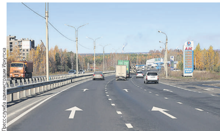
На большинстве объектов работы уже завершены.
