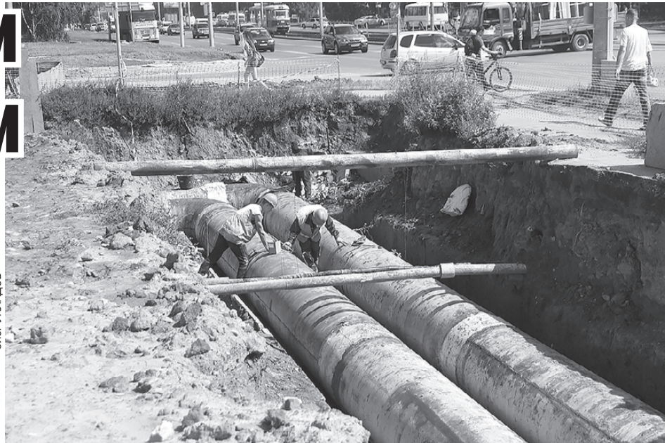
Ремонт на теплосетях начнется уже в ближайшее время.
